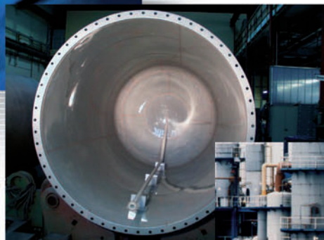
(Foto: Infraserb Hoechst Technik GmbH & Co. KG)
