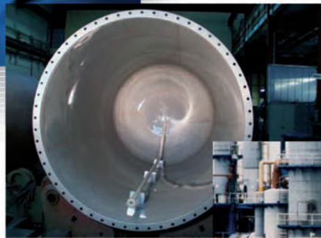
(Foto: Infraserb Hoechst Technik GmbH & Co. KG)
