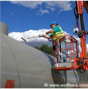
**ISOTEST® Prüfset: Tank & Behälter inkl. ISOTEST® inspect pro**
